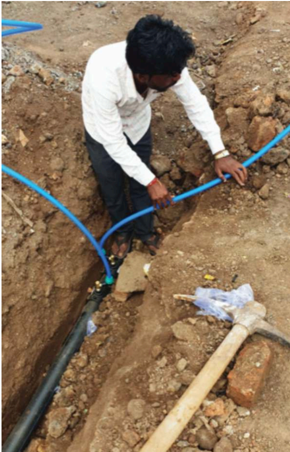
निर्माणाधीन डिस्ट्रिब्यूशन पाइप लाइन कार्य एवं इलेक्ट्रो-फ़्यूजन शैडेल द्वारा घरेलू-नल कनेक्शन कार्य आवर्धन जल प्रदाय योजना, गुना (म.प्र.)
