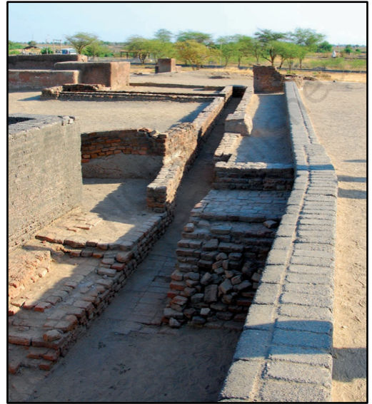
तस्वीर 1: लोथल में घरों से निकलने वाले गंदे पानी को लाने वाली नालियाँ।
